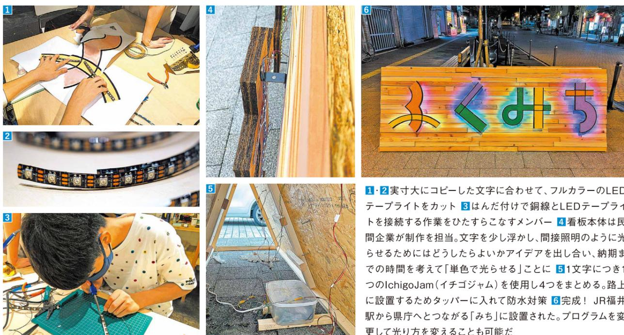
1・2 実寸大にコピーした文字に合わせて、フルカラーのLEDテープライトをカット 3 はんだ付けで銅線とLEDテープライトを接続する作業をひたすらこなすメンバー 4 看板本体は民間企業が制作を担当。文字を少し浮かし、間接照明のように光らせるためにはどうしたらよいかアイデアを出し合い、納期までの時間を考えて「単色で光らせる」ことに 5 1文字につき1つのIchigoJam(イチゴジャム)を使用し4つをまとめる。路上に設置するためタッパーに入れて防水対策 6 完成! JR福井駅から県庁へとながる「みち」に設置された。プログラムを変更して光り方を変えることも可能だ
